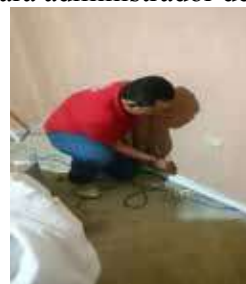
Figura 3. Ubicación de canaletas y equipos de red
